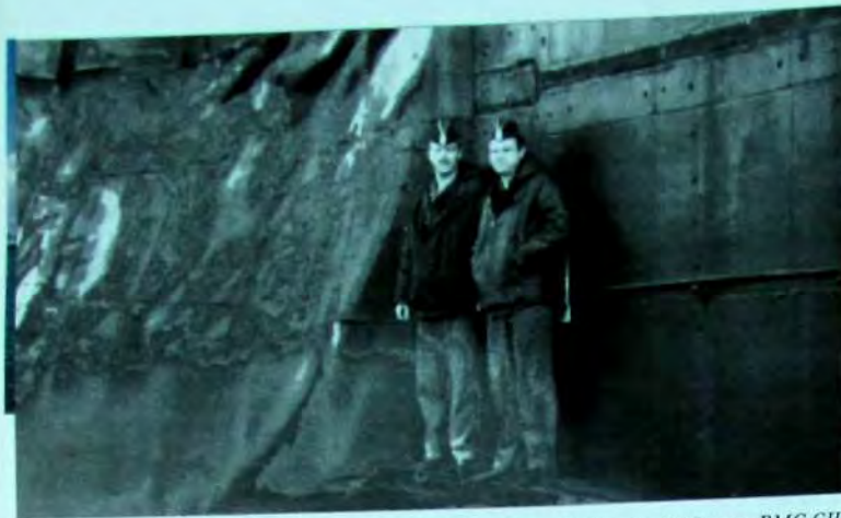
1993 г. На обшивке рпксн К-407 след от удара п/ла «Грейлинг» ВМС США
