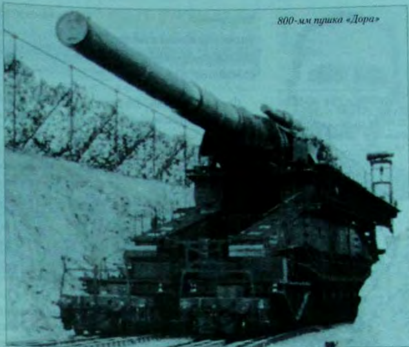
Стрельба пушкой «Дора» велась 7-тонными бронебойными или 5-тонными фугасными снарядами
