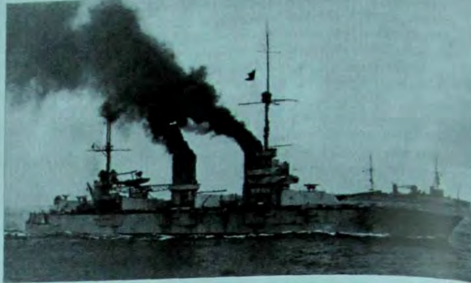
Линейный корабль «Парижская коммуна» с катапульты К-3 и самолетом КР-1
