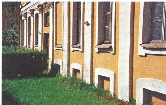
Дом светлейшего князя А. Д. Меншикова на Васильевском острове. В наши дни его цокольный этаж скрывает мостовая. Во время реставрационных работ было установлено, что современный уровень мостовой выше исходного на 1,3 м.
