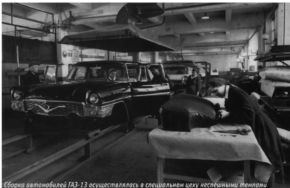
Сборка автомобилей ГАЗ-13 осуществлялась в специальном цеху неспешными темпами
