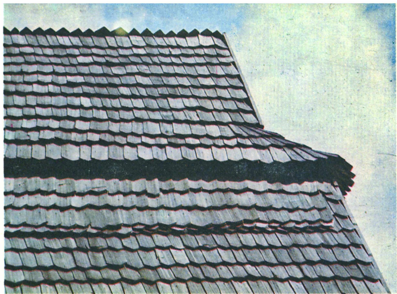
Гонтовая кровля гармонирует с брусчатыми стенами. Фрагмент гонтовой кровли.
