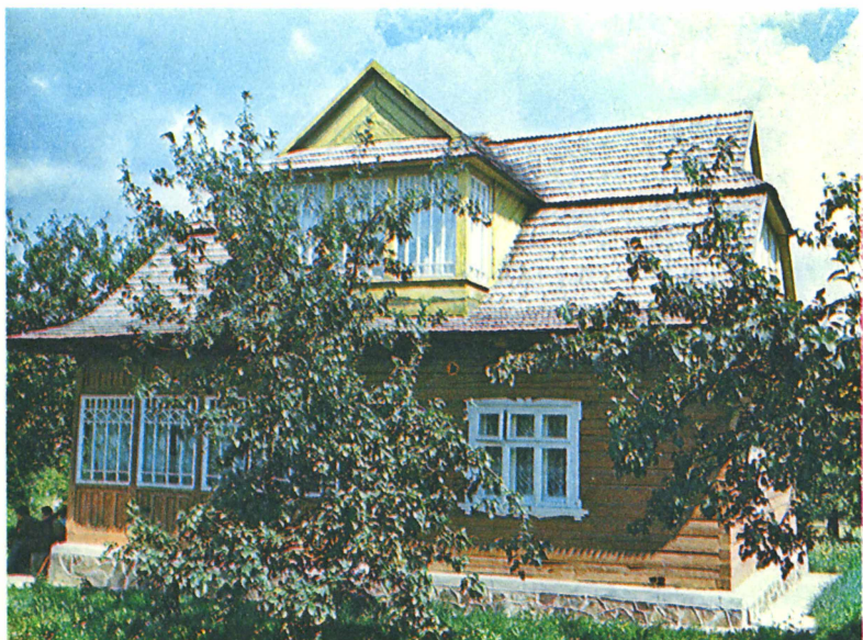
Гонтовая кровля гармонирует с брусчатыми стенами. Фрагмент гонтовой кровли.
