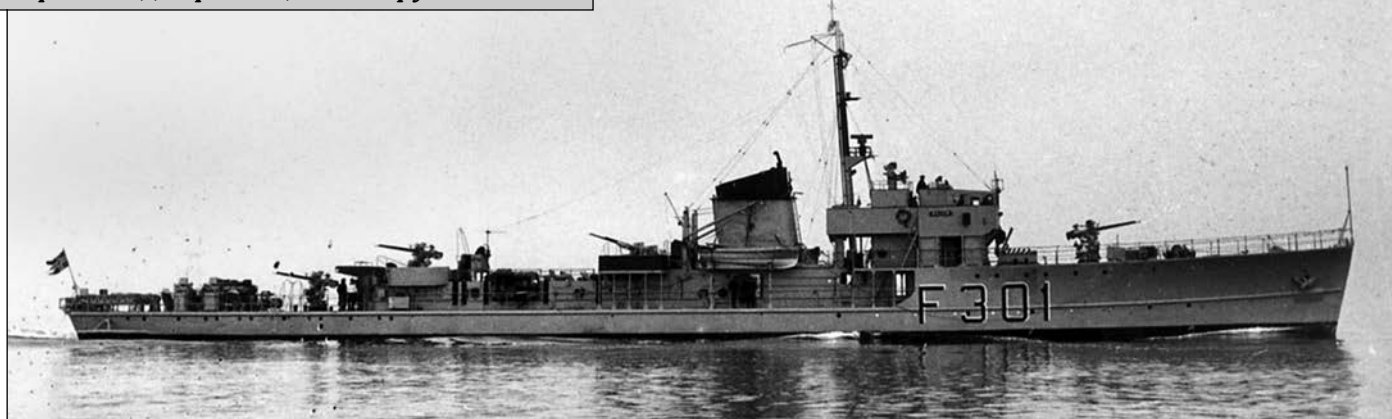
«Гюллер» после переоборудования во фрегат. Хорошо видно размещение вооружения
