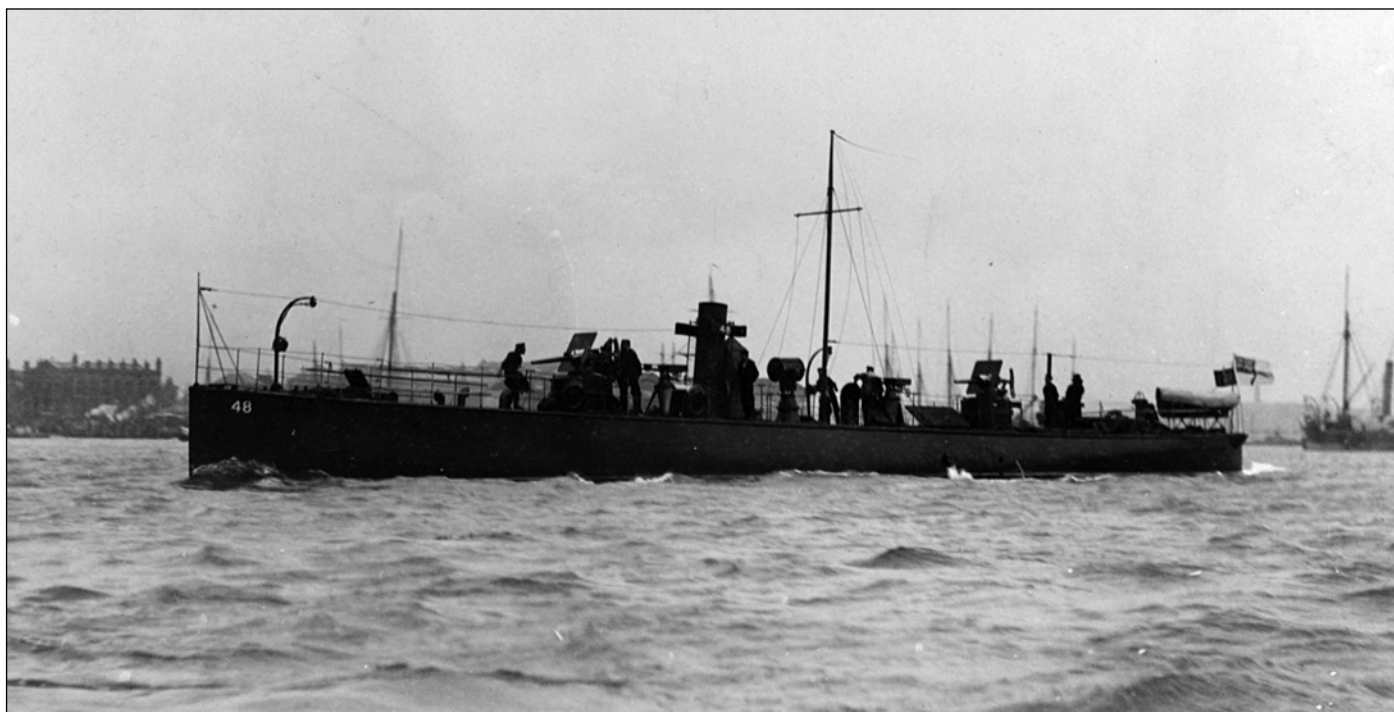
Миноносец ТВ 48 со снятыми торпедными аппаратами и двумя скорострельными пушками, смонтированными на боевых рубках
