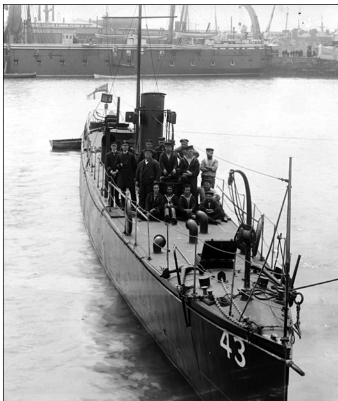
Миноносец ТВ 43 со снятым вооружением, снимок сделан вскоре после окончания перестройки носовой оконечности
