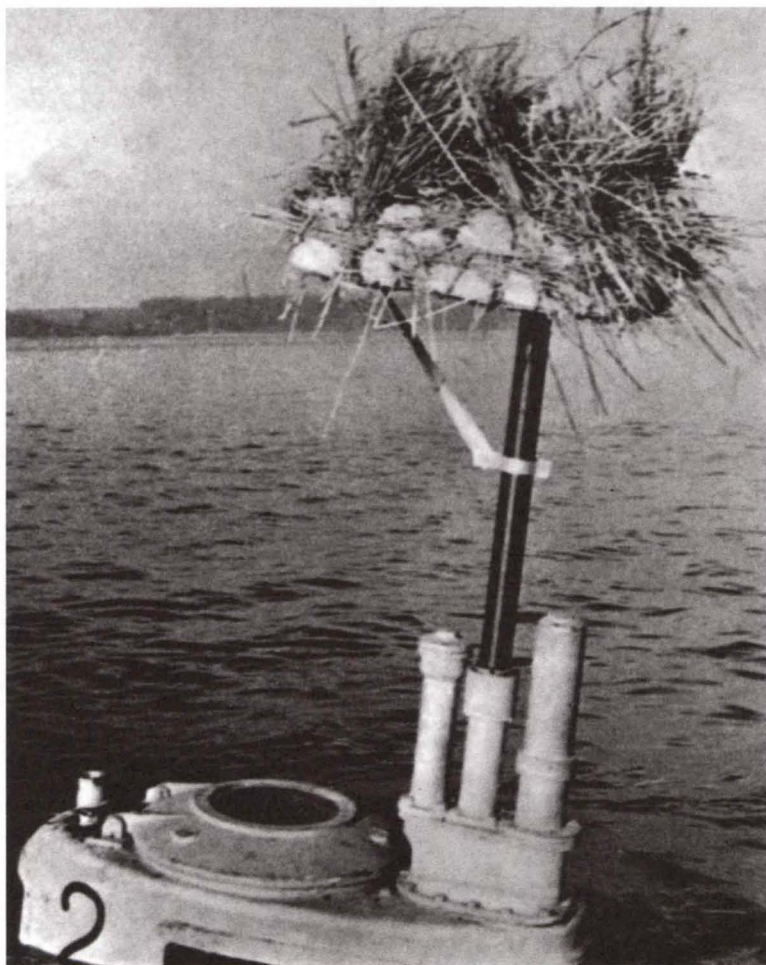
Водители «биберов» часто маскировали перископы сво- их подлодок под плавающие птичьи гнезда. Данные фо- тографии сделаны на Балтийском море в начале 1945 г.
