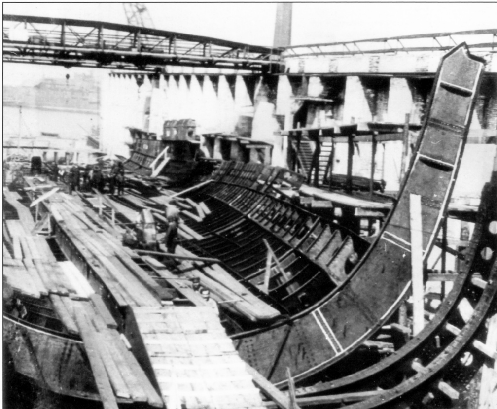
«Бородино». Формирование корпуса носовой оконечности корабля по состоянию на 10 июля (вверху) и 10 ноября 1913 года
