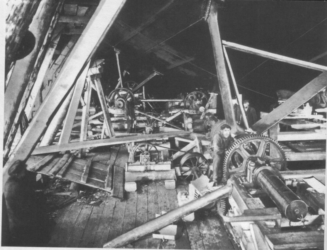
Линейный корабль «Полтава» на стапеле. Вверху: расточка кронштейнов гребных валов. Внизу: гребные винты и малый руль после завершения монтажных работ, июнь 1911 г.
