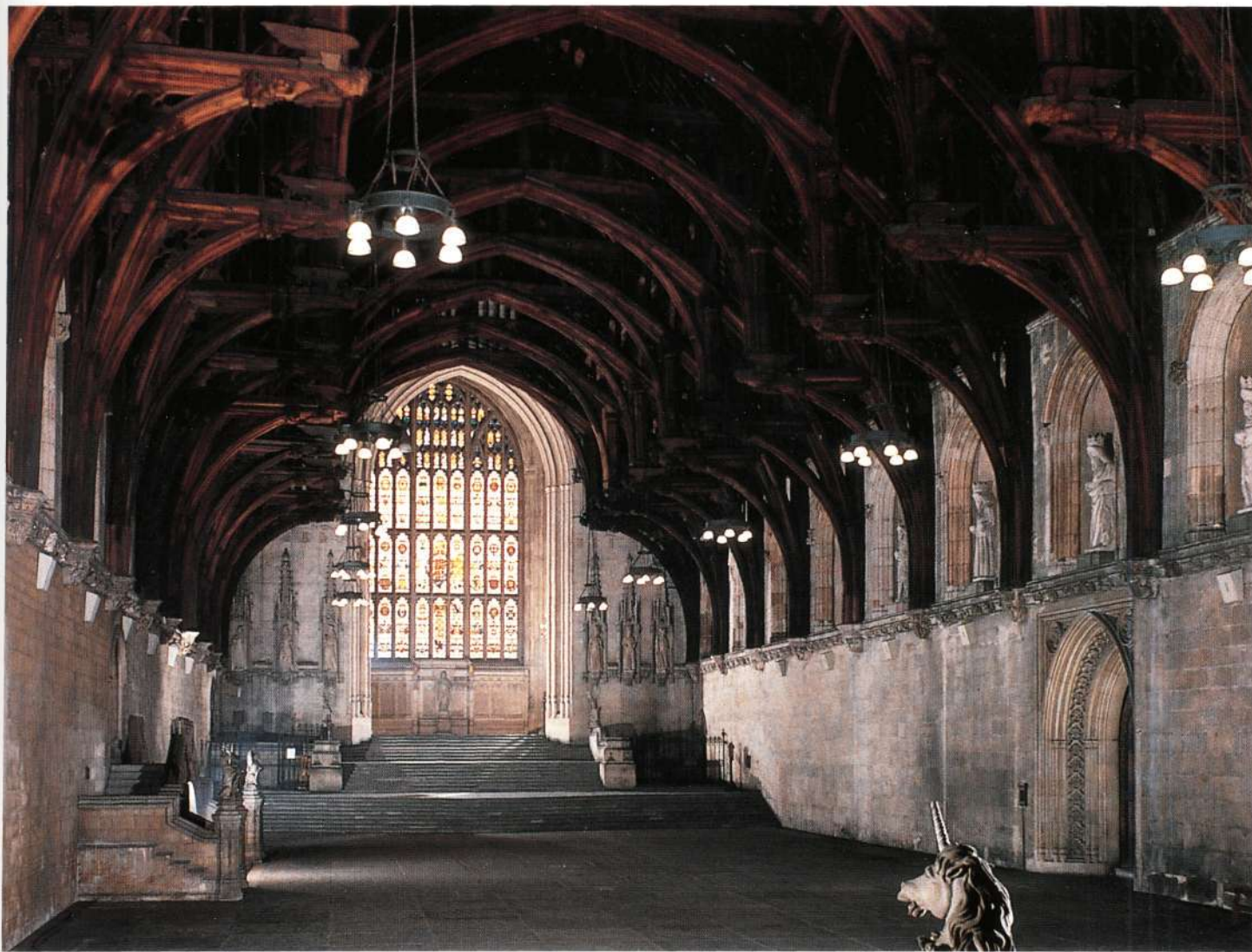
6. Вестминстерский зал старого королевского дворца в Вестминстере. Лондон, 1394—1401. Зал был выстроен во времена норманнского завоевания, а при Ричарде II перекрыт роскошным деревянным потолком с балками причудливых готических очертаний.
