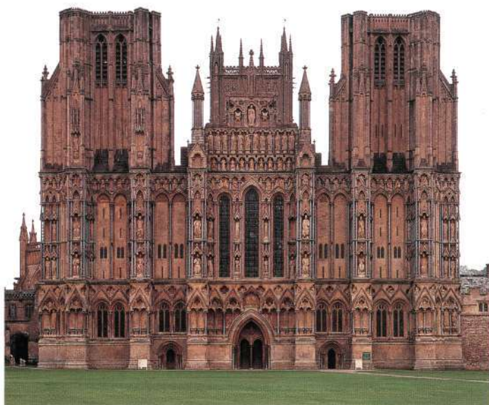
8. Западный фасад собора в Уэлсе (Англия, начат в 1230). Портал единственного входа малозаметен. Сам фасад шире нефа, находящегося позади него — он выглядит, скорее, архитектурным «задником» скульптуры, а не собранным, «волевым» началом, как в Реймсе и Лане. Первоначально все фасады были полихромными: скульптура ярко выделялась на красном и синем фоне.
