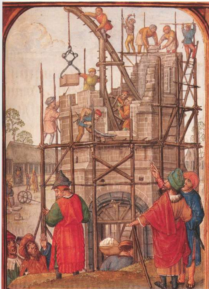
7. Вавилонская башня. Миниатюра в часослове. Нидерланды, конец XV века. Художник детально изобразил леса, лестницы и кран, работающий с помощью колеса, установленного внутри здания.
