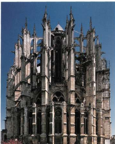
2, 3. Самым высоким готическим собором стал собор в Бовэ (начат в 1225), но в 1284 году, когда были построены хор и башня транспта, свод обрушился, и собор пришлось перестраивать, укрепив его контрфорсами.
