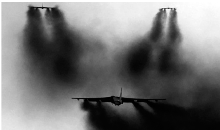
Звено из трех самолетов В-52 — основная тактическая единица времен Вьетнамской войны. Густой черный дым — результат впрыска воды в двигатель во время взлета.
