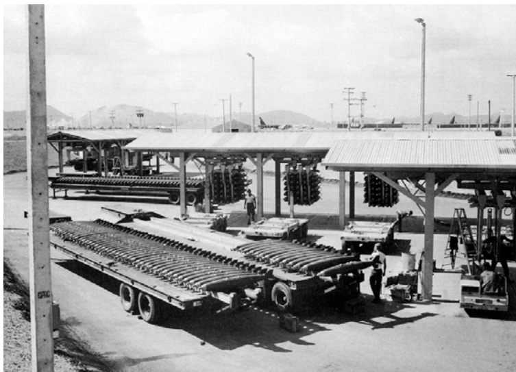
Из-за нехватки бомб М 117 оружейники базы У-Т в 1969 году загружали в контейнеры В-Bay более легкие бомбы — Mk 82. Контейнеры В-Bay висят на тельферах под навесом.
